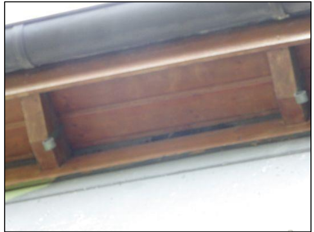
Abbildung 55: Holzverlattung des Dachüberstandes mit potenziellen Brutnischen für Gebäudebrüter.
