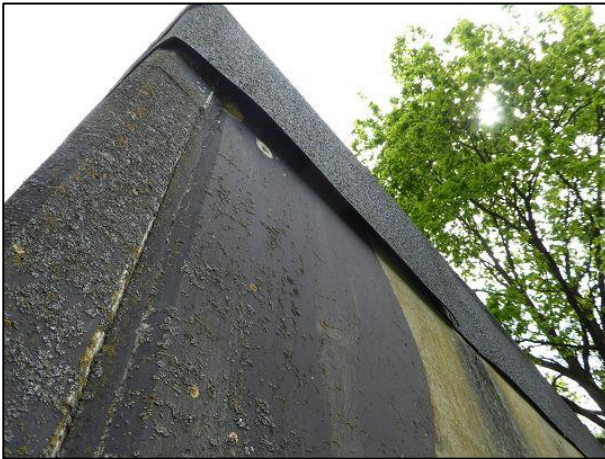
Abbildung 36: Dachanschlußbereich mit Spalten als möglicher Zutritt zum Gebäude bzw. möglicher Hohlräume unter der Dachabdeckung.
