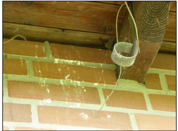
Abbildung 13: Vogelkots Spuren im Übergangsbereich von Mauer zu Dachüberstand
