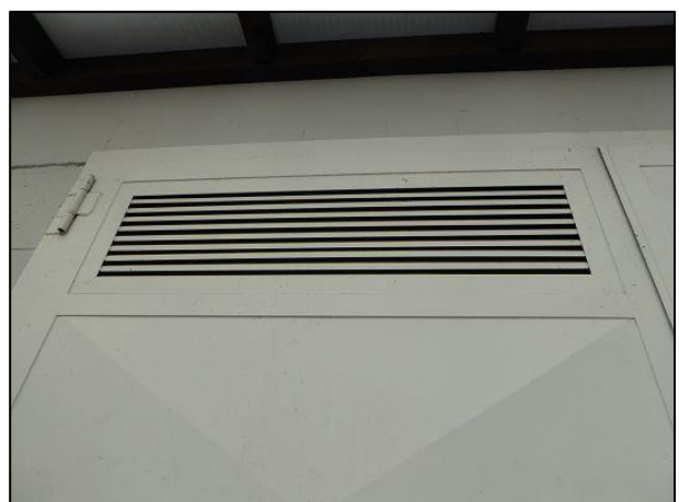
Abbildung 33: Die Lüftungsschlitze in den Türen zum Technikgebäude sind zu schmal für den Einschluß.
