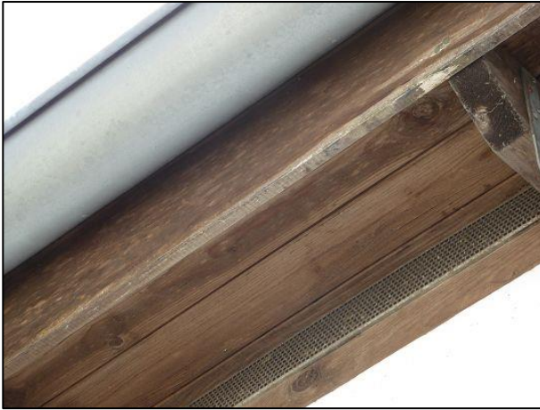
Abbildung 28: Dachabschluss mit Holzbeplankung und potenziellen Hohlräumen.
