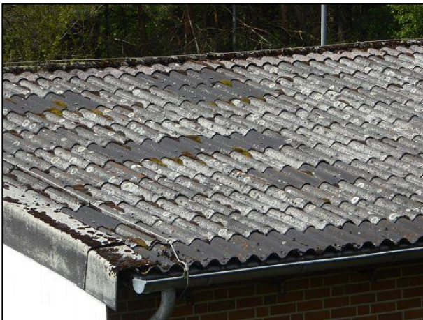
Abbildung 30: Welleternit-Dachbedeckung mit potenziellen Brutplätzen für Gebäudebrüter.
