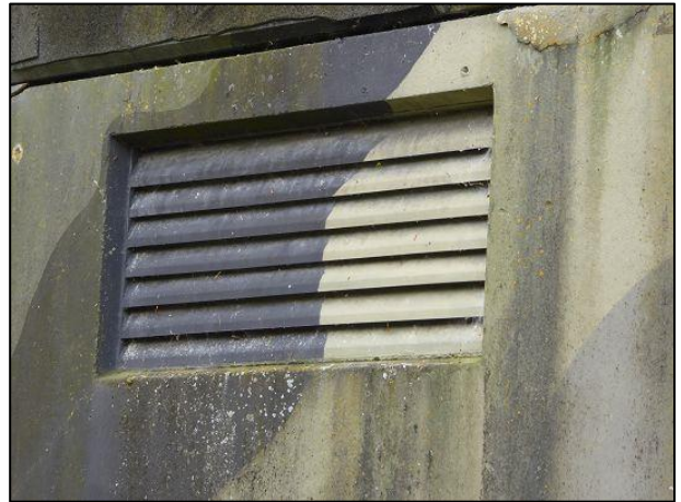
Abbildung 37: Lüftungsschlitze eignen sich kaum zum Einschlüpfen von Fledermäusen in das Gebäude.
