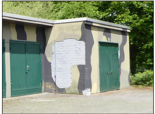
Abbildung 22: Abgeplatzter Putz ohne Versteckmöglichkeiten.
