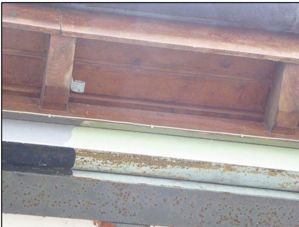
Abbildung 42: Der Dachüberstand ist mit Holz verlattet und bildet potenzielle Nischen.
