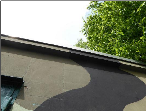
Abbildung 21: Dachüberstand mit Dachabschluss (Metall-Verblendung).
