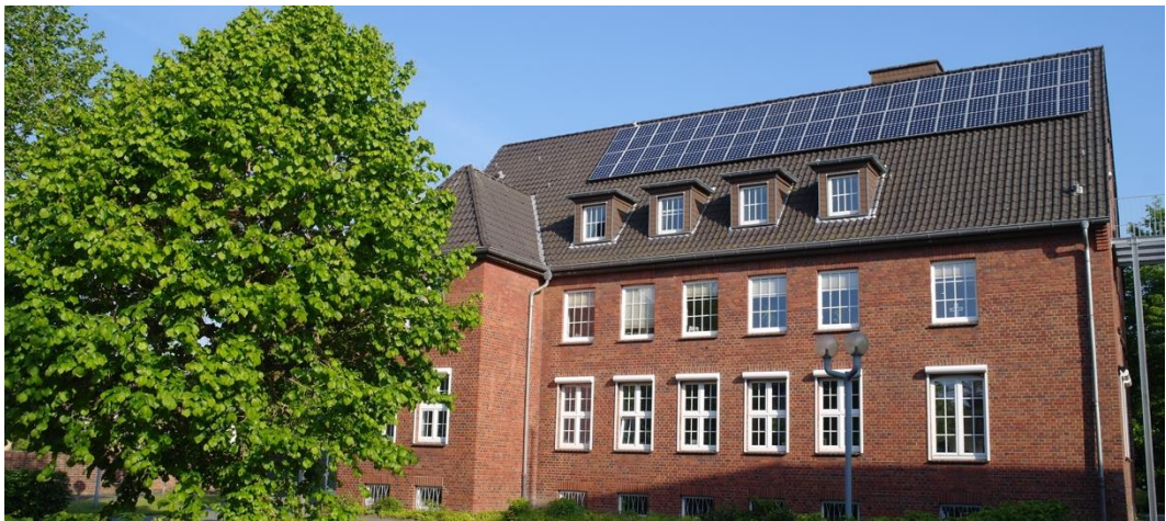
Abbildung 38: Photovoltaikanlage am Gebäude des Sozialdienstes Katholischer Frauen
