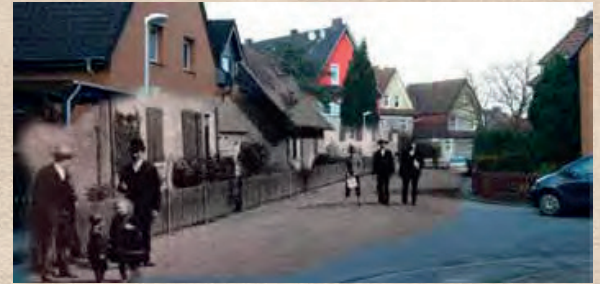
Die Burgenlandstraße im Beisenkamp: Alte und neue Zeiten sind in diesem Bild vermischt. Foto: Carsten Majewski
