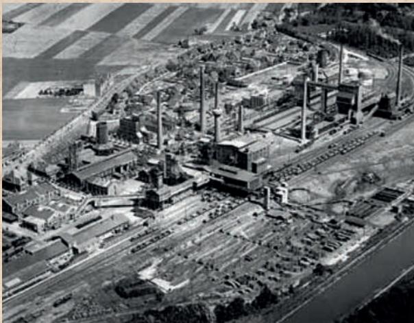
Die ehemalige Zeche Emscher-Lippe I-II aus luftiger Höhe.
